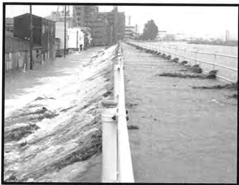
庄内川水位が高く合流出来ずに越水する八田川（H23 春日井市御幸町）
